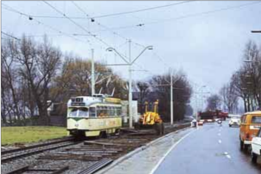
De trambaan langs de Delftweg werd in de jaren 1978-'80 in drie fasen vernieuwd. PCC-car 121.? rijdt over het al vernieuwde spoor richting Den Haag bij 's-Gravenmade, terwijl het spoor richting Delft wordt uitgebroken, 13 maart 1979. Het maken van een thermietlas tussen railstaven bij Driehuizen (Bouwlust), 20 maart 1979. FOTO's: J. BLOK
